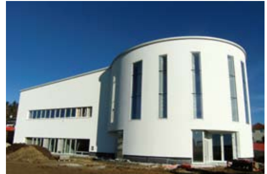
Südansicht des noch im Bau befindlichen neuen Seelsorgezentrums Lichtenberg
