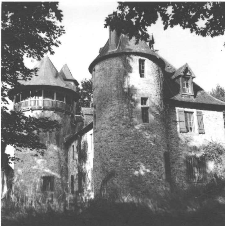
OSE-Heim Château du Montintin im Département Haute-Vienne in der Nähe von Limoges.
